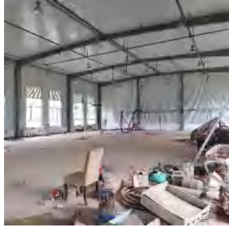
厂房内部情况
